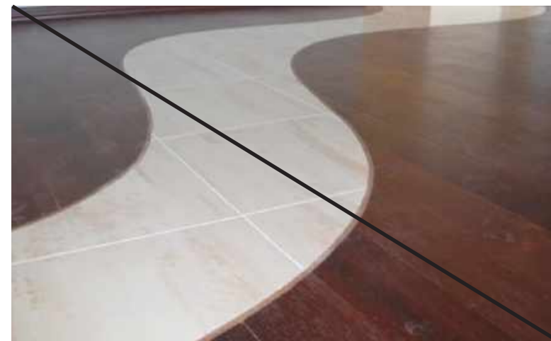
Плохо Узорные стыки из разных материалов
