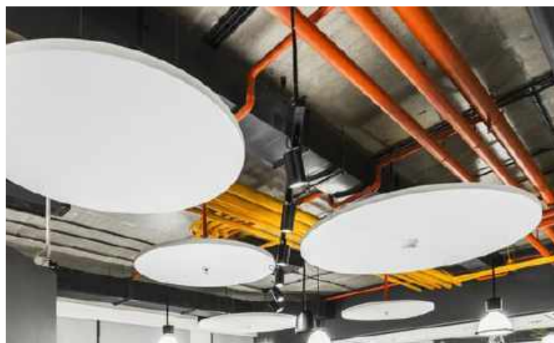
Акустические подвесные системы. Могут быть разных геометрических форм. Рекомендуется использовать белые без цветных вставок
